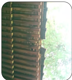
右の写真の落ちた屋根瓦 屋根瓦が落ちて隙間が
